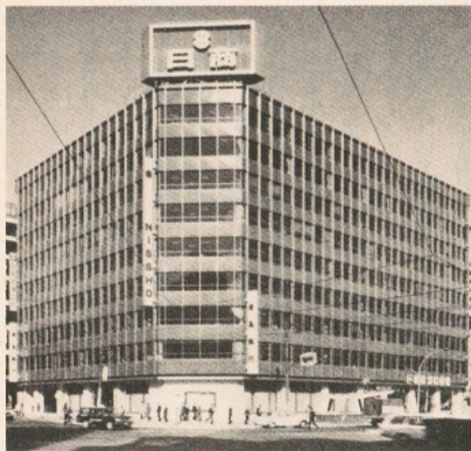
鈴木商店は再建され「日商」(東京支社)となった(昭和四十三年)
