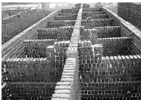
写真3；鍍レンガで造られた貯蔵庫と思われる（2007年1月）
