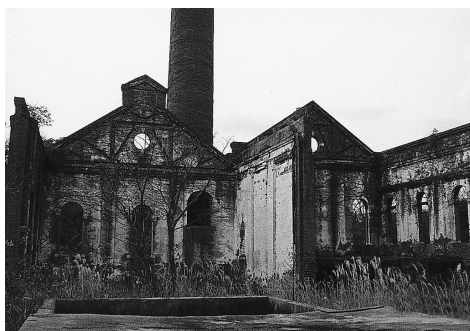
写真4；発電所の遺構（2007年1月）
