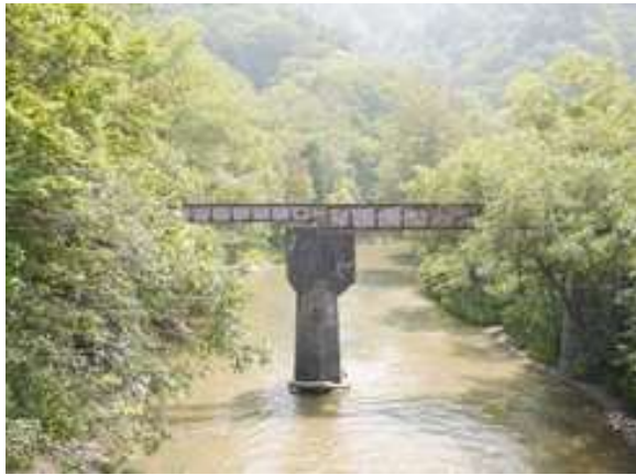
第二橋梁（車窓から見学）
