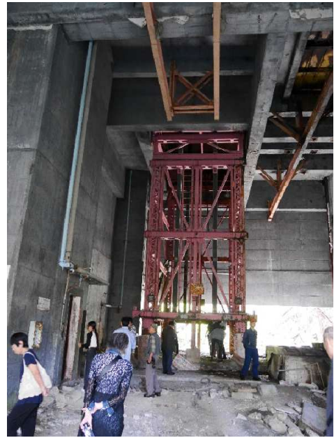
羽幌本坑の運搬立坑巻上げ塔内部
