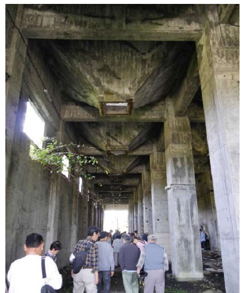
羽幌本坑貯炭場の漏斗型の精炭ポケット
