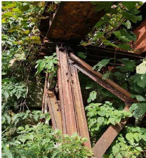
第三橋梁のレールによる橋台の補強部分
