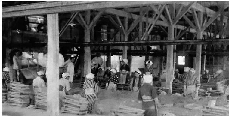
写真 2 鉍滓煉瓦手成型作業（『八幡製鐵所化工部外史』より）
