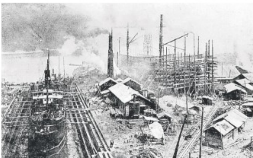
船台や工場の建設が進む1917(大正6)年ごろの造船所
